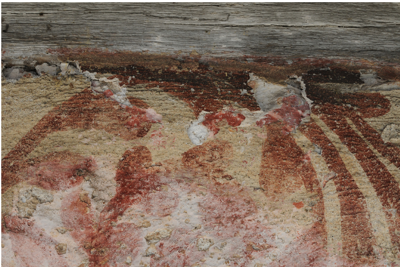
Södra sidan. Detalj av 1920-talets rekonstruktion vid anslutningen mot hammarbandet. Bilden visar parti med blottlagd originalmålning.
