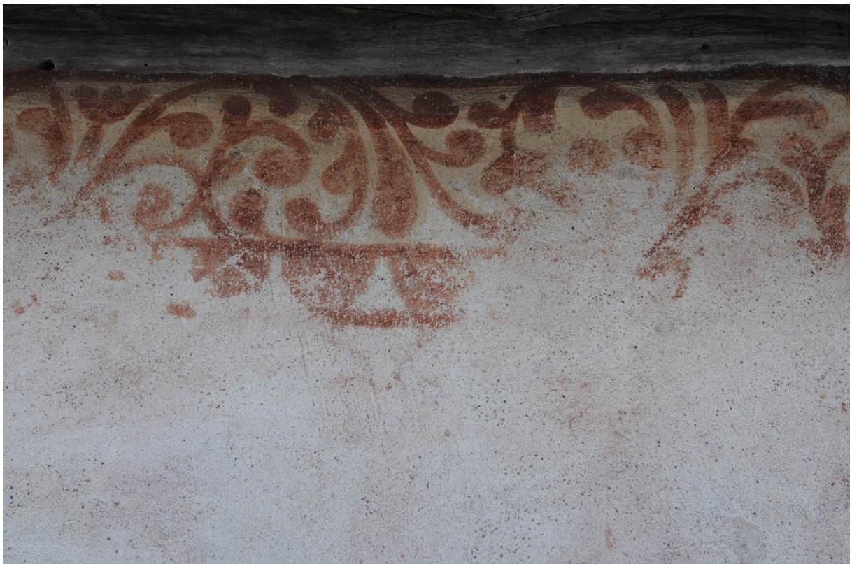
Parti över nordsidans västra fönster.
