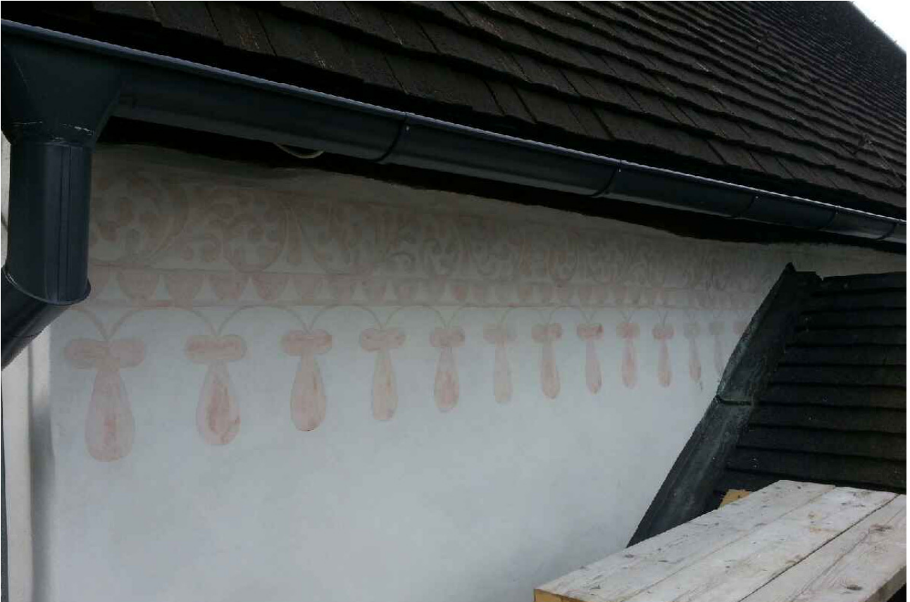
Norra sidans östra del. Efter utförd undermålning.
