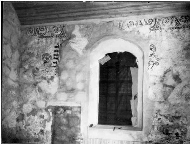
Parti av södra långhusmuren interiör under 1928-29 års restaurering. Bilden visar det igensatta äldsta fönstret och under detta den igensatta portalen.
