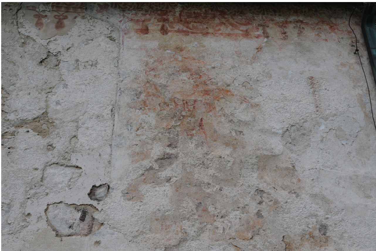
Parti av sydsidan med äldre fönster och översikt av fragmentet med ängel.
