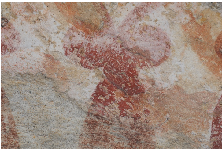
Södra sidan. Detalj av treklöverblad från äldre dekorationskiktet. Nederst i bild 1900-talets överslamning.
