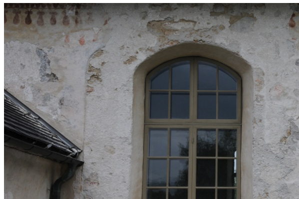
Norra långhussidans äldre igenmurade fönster.
