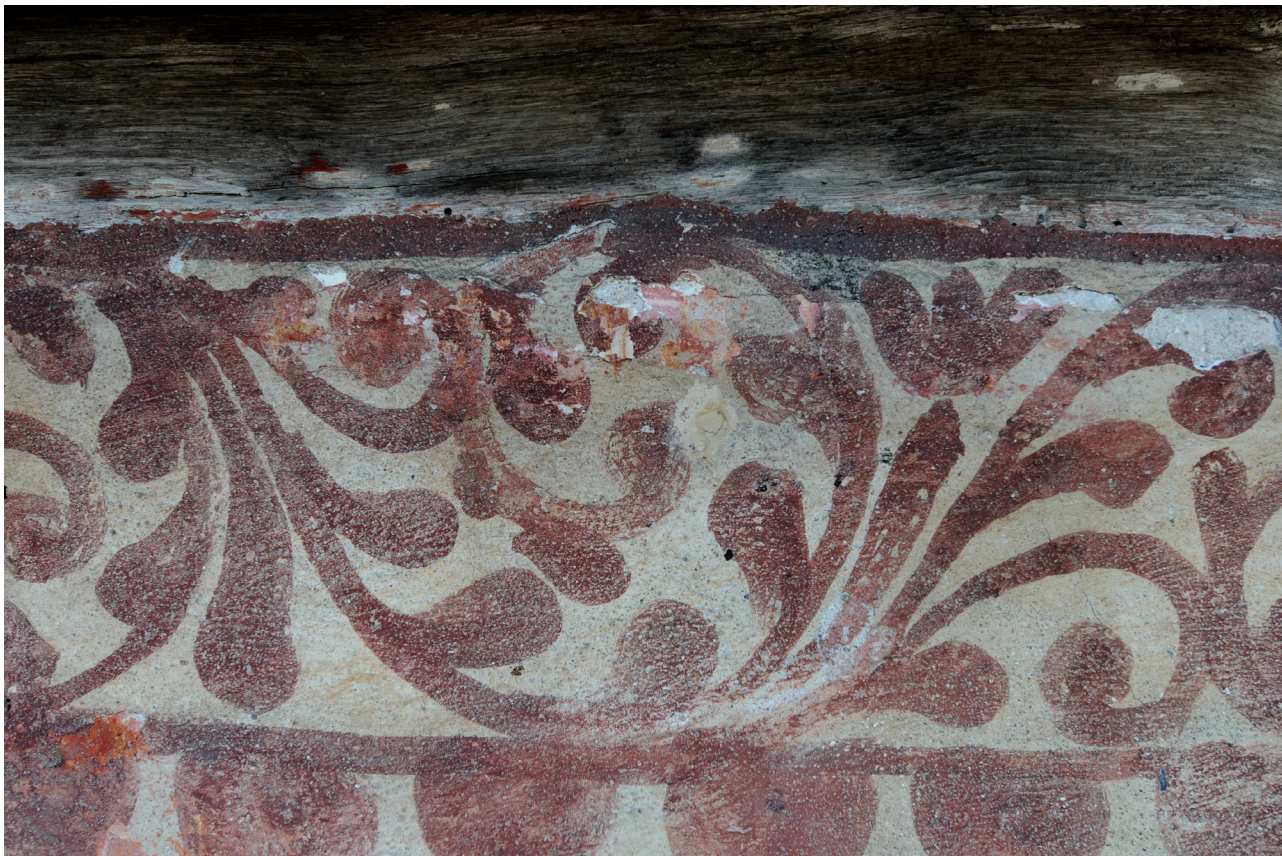
Parti från norra sidan med 1920-talets rekonstruktion vid undersökningens inledning. I bildens mitt och nedre vänsta hörn syns injektionshål med ilagningar och retusch från 1974 års arbeten.
