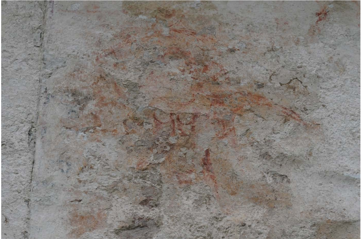
Ytan lätt fuktad.
