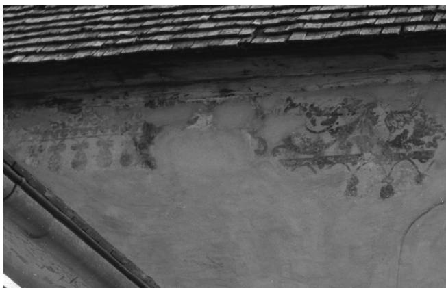
Parti av norra långhusmuren över sakristian. Bilden visar fragment av de båda bårderna, den äldre t.v. och den yngre t.h., frilagda under 1928-29 års restaurering. Foto: Paul Boberg.
