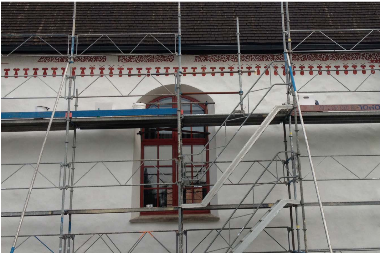
Norra sidan under utförande.
