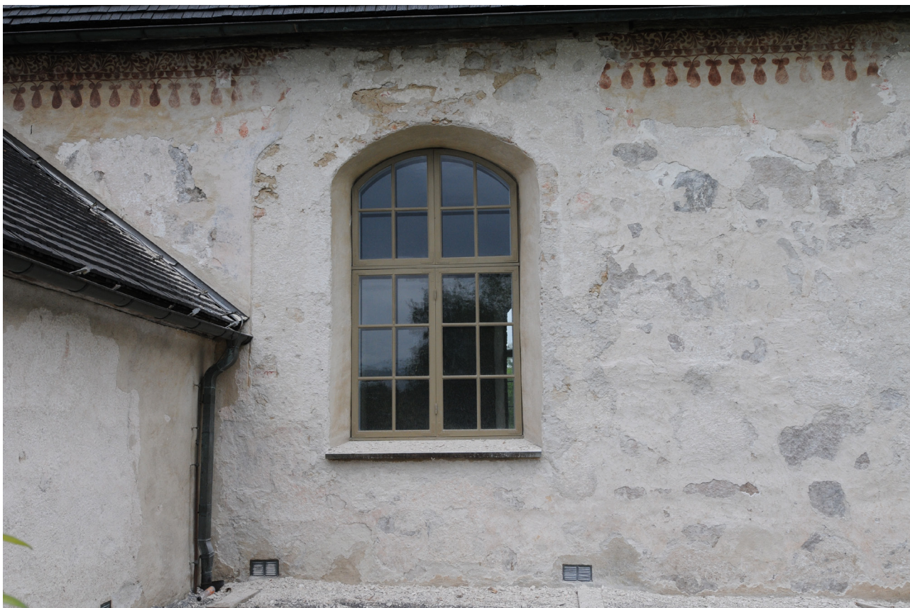
Norra långhussidan väster om sakristian vid undersökningens slutskede.
