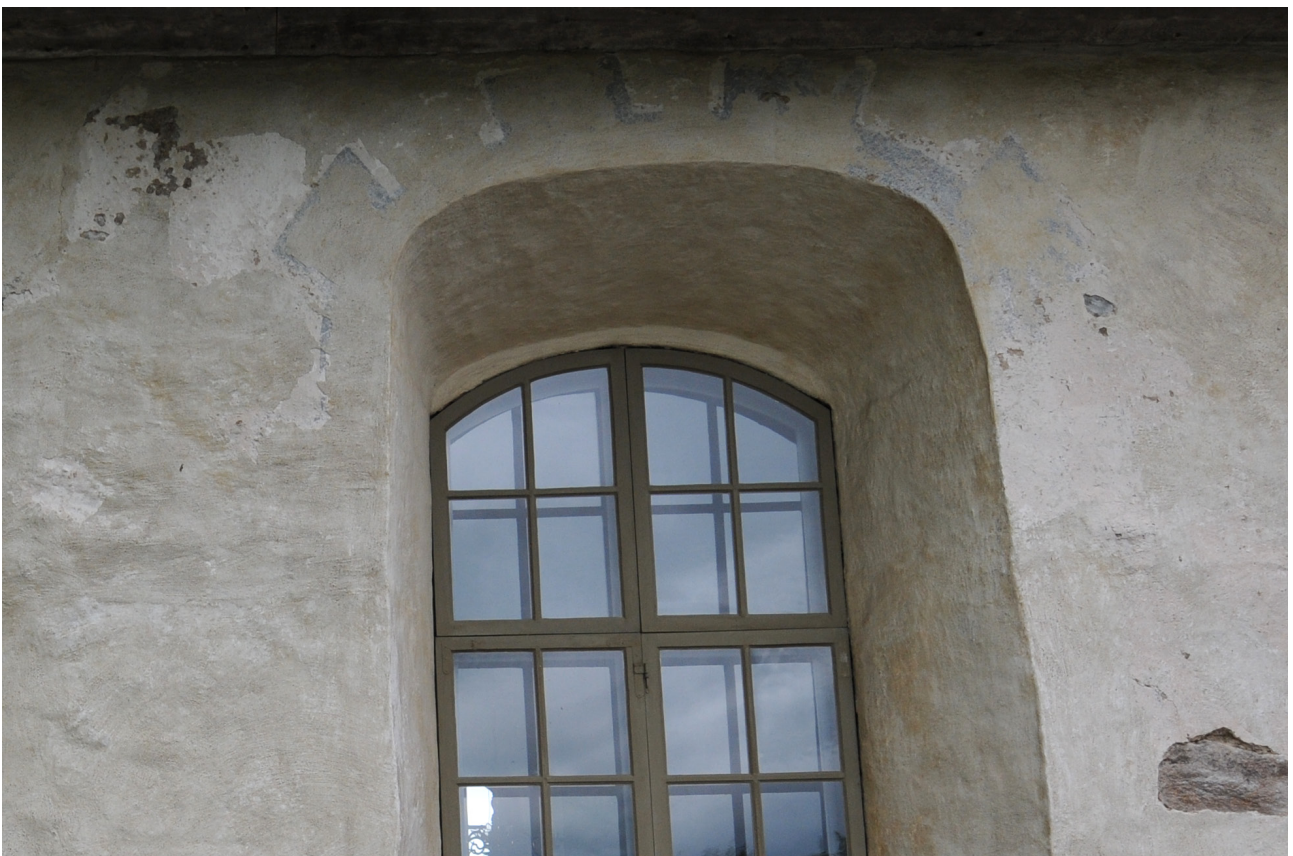
Detalj av kvaderkedja runt fönster.
