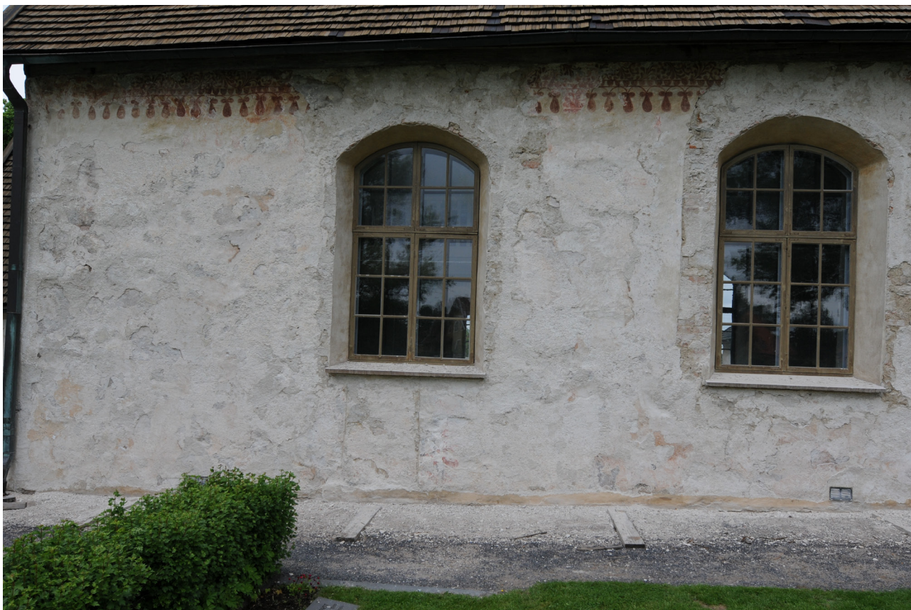
Södra långhussidans västra hälft vid undersökningens slutskede.
