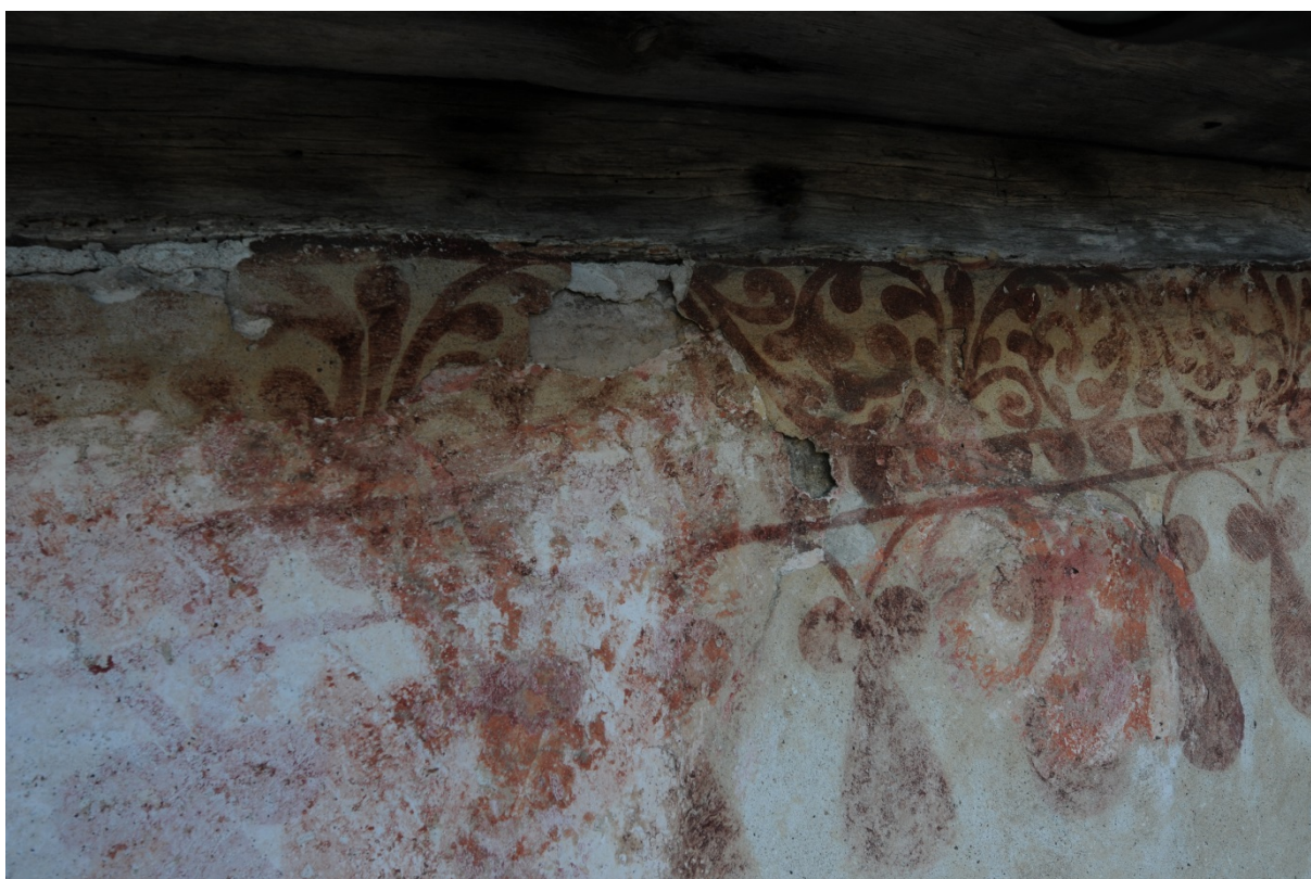
Parti från södra sidan. Bilden visar uppskalning och bortfall i putsskiktet och bortfall i anslutningen till hammarbandet.
