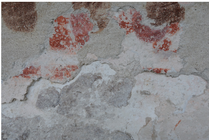
Detalj från norra sidan. Äldsta putsskiktet med påtagligt vitare kalkavfärgning än yngre avslutande skikt.
