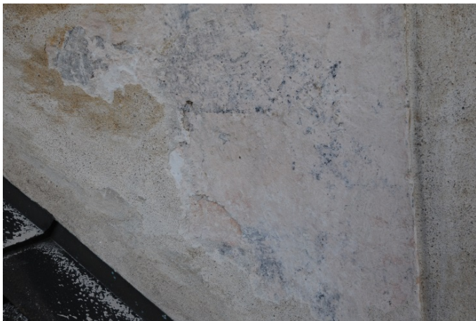
Detalj från norra sidans äldre fönster. Rosa kalkavfärgning som botten för kvadermålning.
