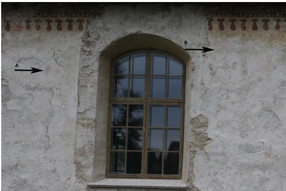
Målningsfragment vid södra långhusväggens mittfönster. Se detaljbilder på nästa sida.
