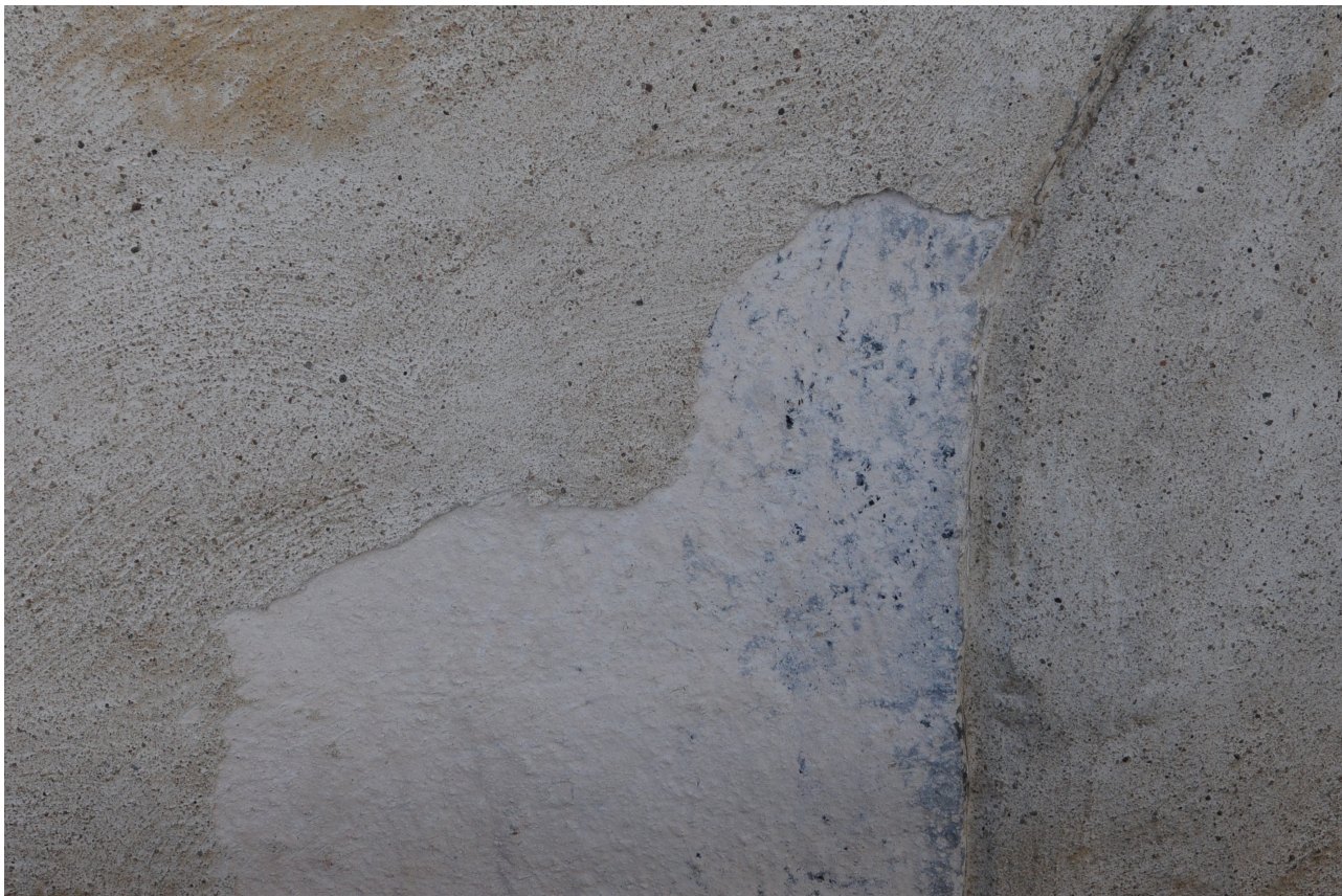
Kvaderkedja vid norra långhussidans igensatta äldre fönster. Målningssytan endast täckt av 1920-talets tunna slammingskikt.
