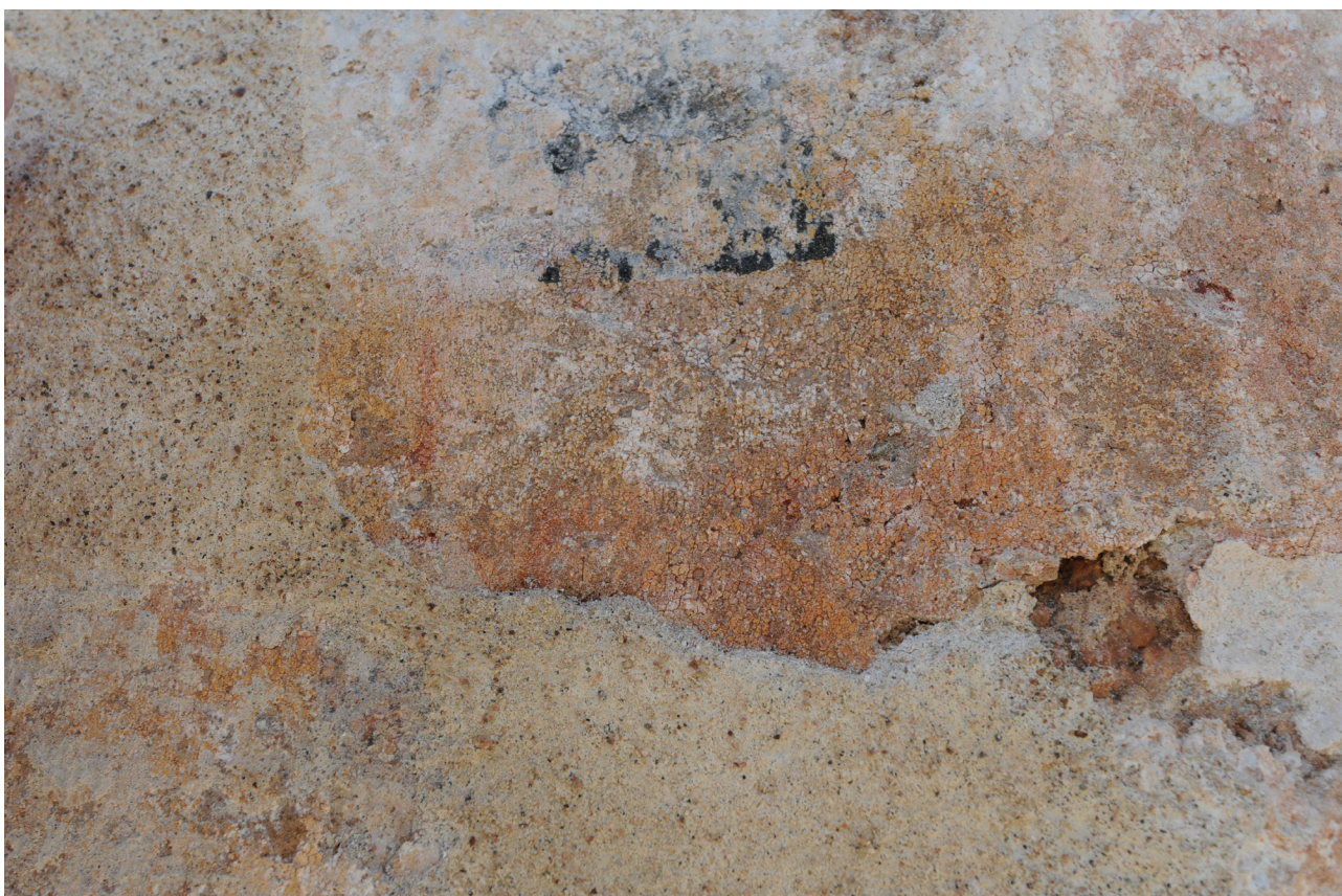
Detalj av gul-orange avfärgning på övre östra delen av långhusets sydsida. Skiktets finmaskiga krackelyrer indikerar innehåll av organiskt bindemedel.
