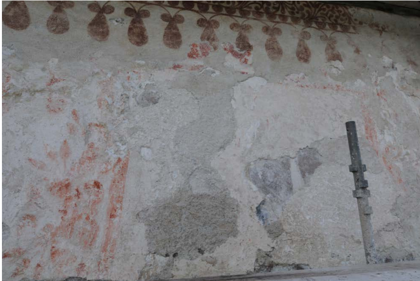
Nordsidans kartusch. Sidoornamenteringen ses t.v. och den rektangulära formen kan utläsas genom det vinkelräta övre högra hörnet som ses strax över och t.h. om ställningsstolpen.
