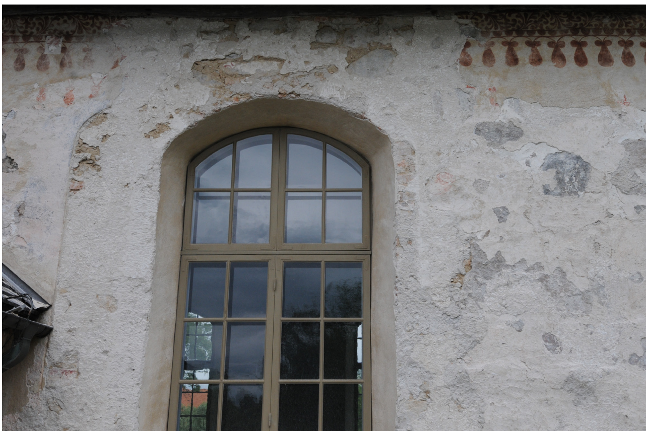
Parti på norra långhussidan med igenmurat fönster vid sakristian av samma typ som på södra sidan. Med kvaderkedja till omfattning.
