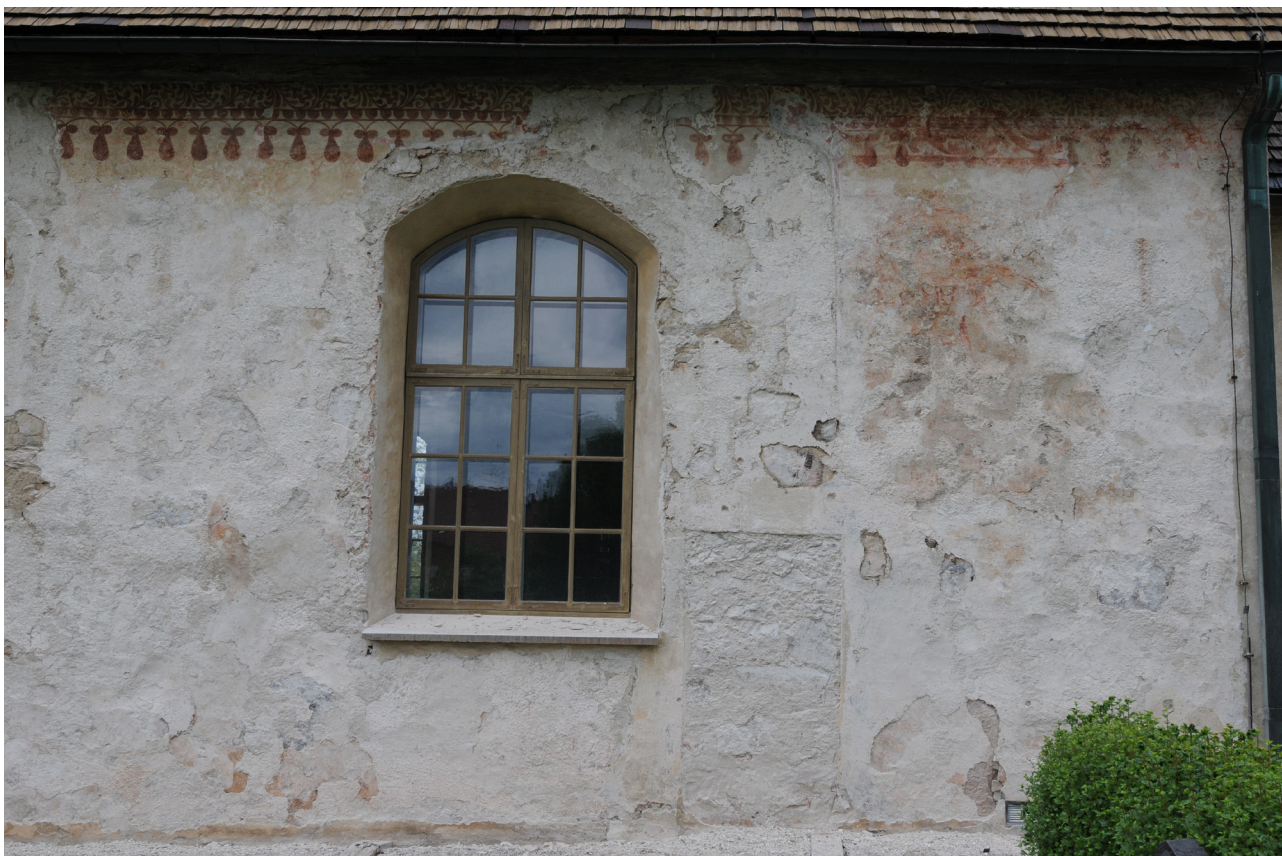
Södra långhussidans östra hälft vid undersökningens slutskede.
