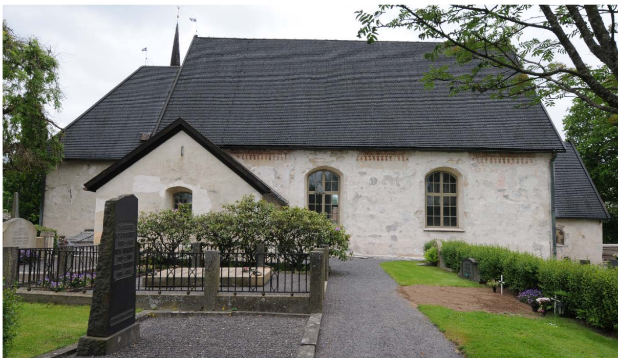
Kyrkan sedd från norr. Foto efter undersökning 2012.
